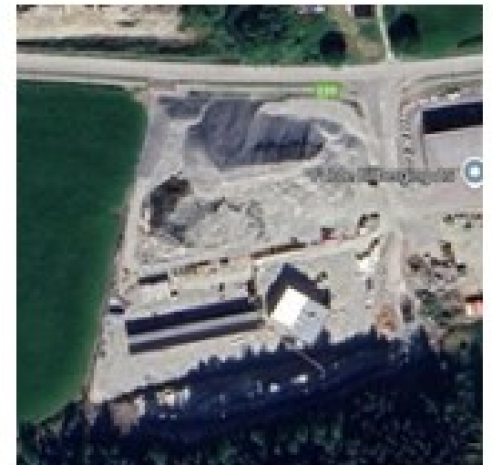
Bygg under oppføring (2025)
